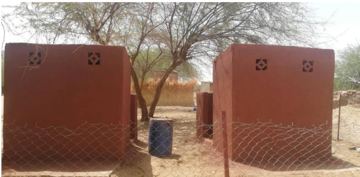
Remarquez les aérations, autre technique liée à l'ancrage de la toiture pour éviter que les tôles ne se détachent en cas de fort vent.
