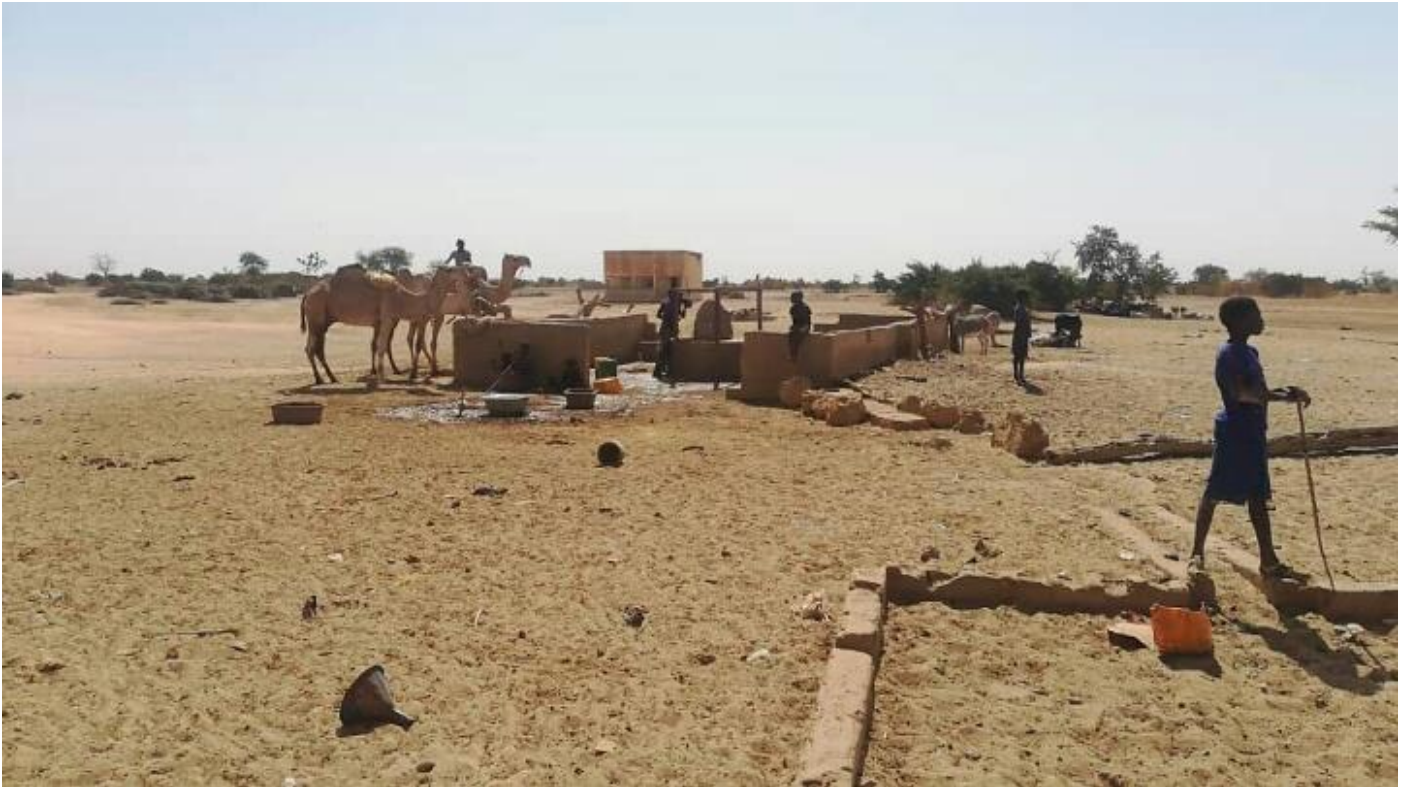
Ci-dessus photo prise le 2 décembre, ci-dessous octobre 2010. Le muret de l'enclos a souffert à l'usage du fait des frottements de la corde lors de la traction d'extraction exercée par l'âne ou le dromadaire, mais l'ensemble du corps du puits et la potence demeurent en bon état. Activité intense autour de ce point d'eau (photo du 22/12/2021) :
