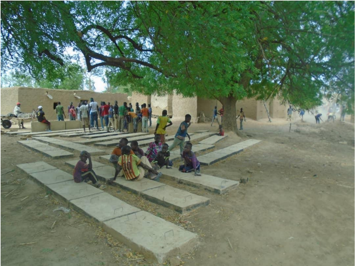
Photos prises le 6 juin 2020 : après une semaine de séchage, les plaques sont chargées sur la charrette tractée par un âne pour être acheminées tout le long du canal pour recouvrement du caniveau en forme de U.
