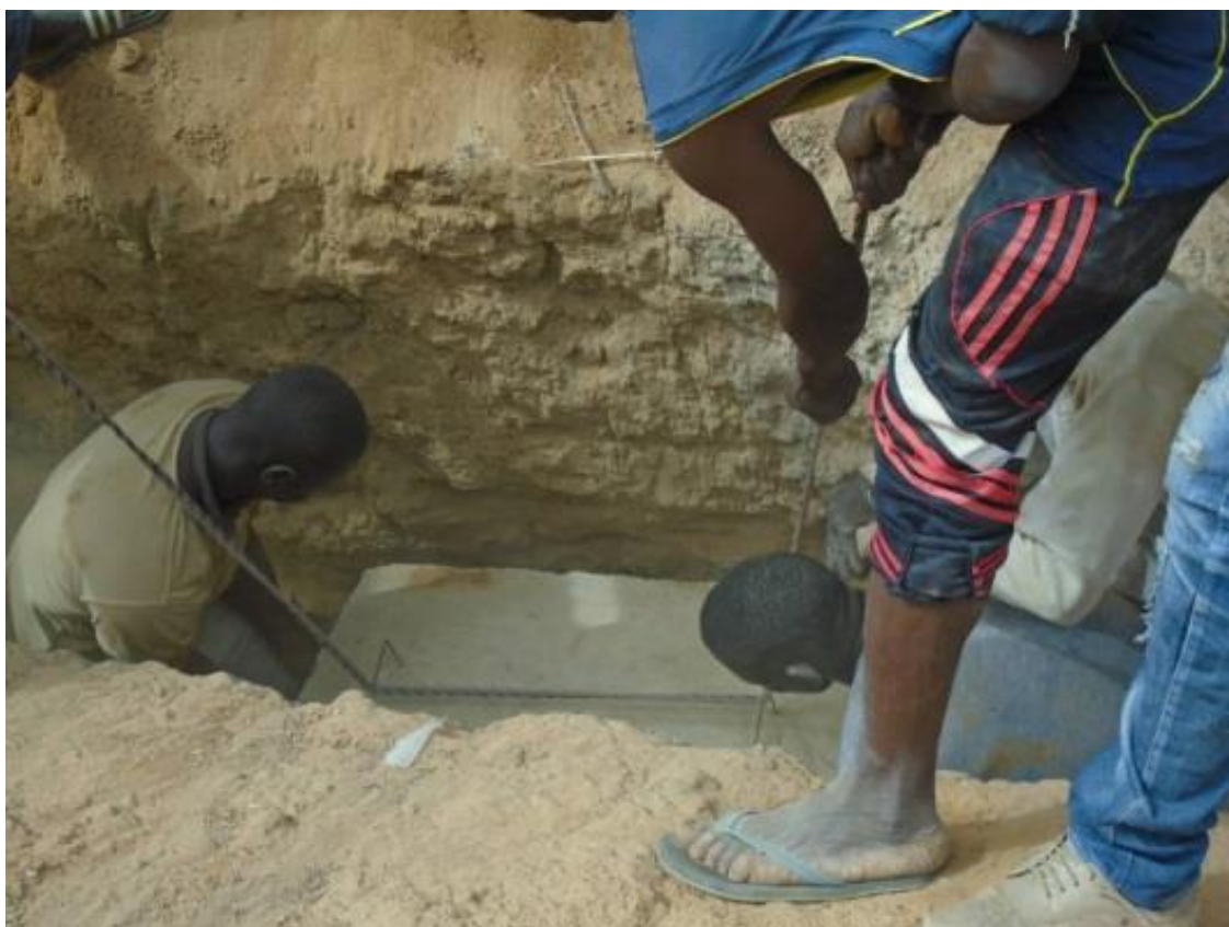
Maçonnage de l'avaloir et remise en état de la place du village et de « la route ».
