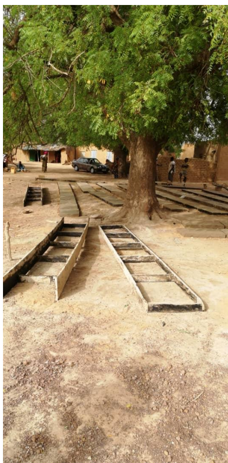
Photos prises par Rober Ansama TOGO, correspondant local officiel de Mali-Médicaments, le 28/05/2020 : Fabrication des plaques de recouvrement, séchage.
