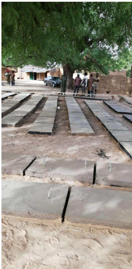
Photos prises par Rober Ansama TOGO, correspondant local officiel de Mali-Médicaments, le 28/05/2020 : Fabrication des plaques de recouvrement, séchage.
