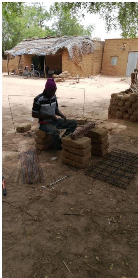
Préparation ferrailage ossature pour les dalles de béton de recouvrement du canal d'évacuation en forme de U
