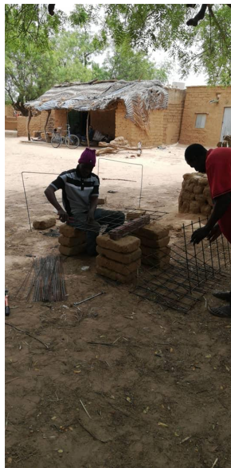
Préparation ferrailage ossature pour les dalles de béton de recouvrement du canal d'évacuation en forme de U
