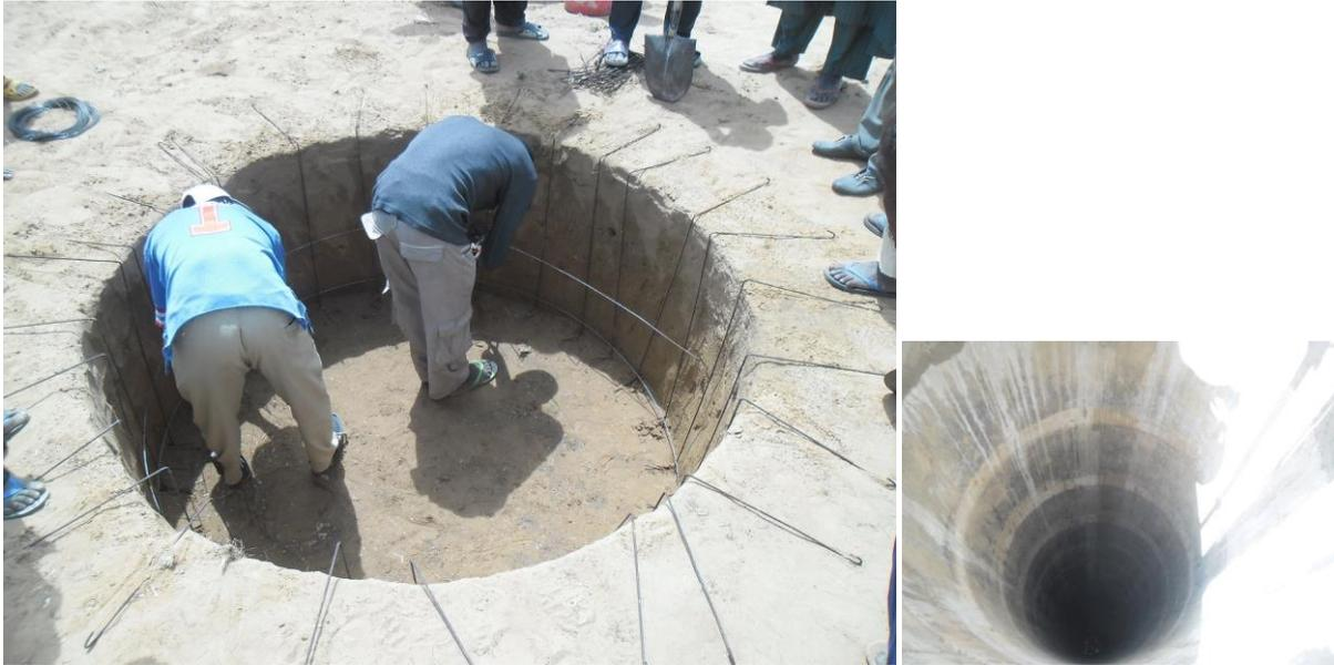
*Ferrailage, busage – Corps du puits*
