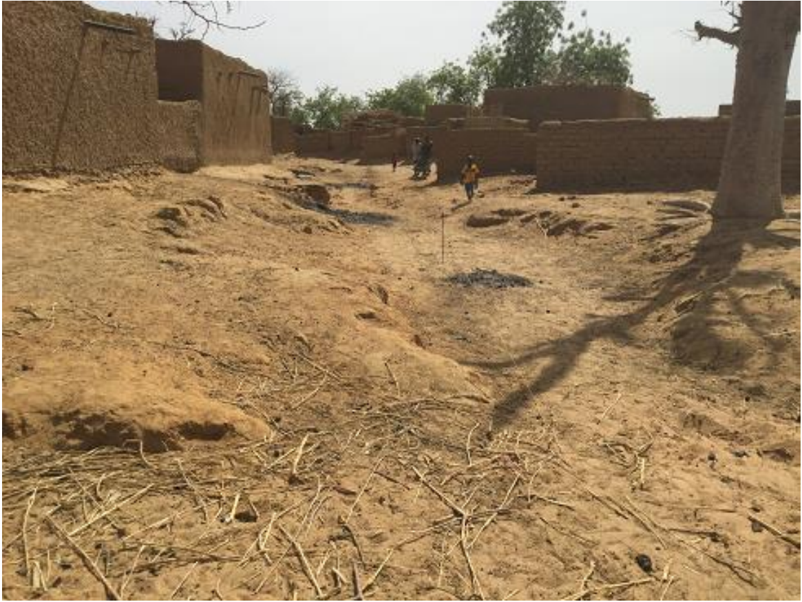
Le tracé de la canalisation E.P. (remarquez les piquets et le fil)
