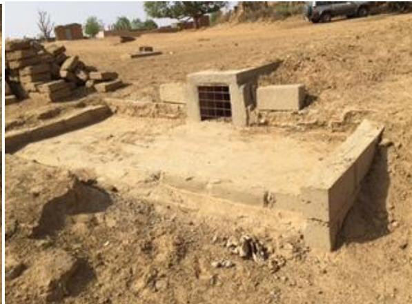
Réalisation d'un avaloir en partie haute avec grille de protection et renforcement des berges pour la mare en partie basse avec déversoir.
