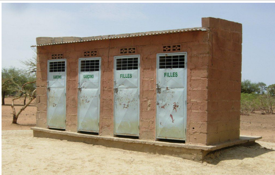
Image 4 : latrines partagées pour les filles et les garçons (Burkina Faso)
