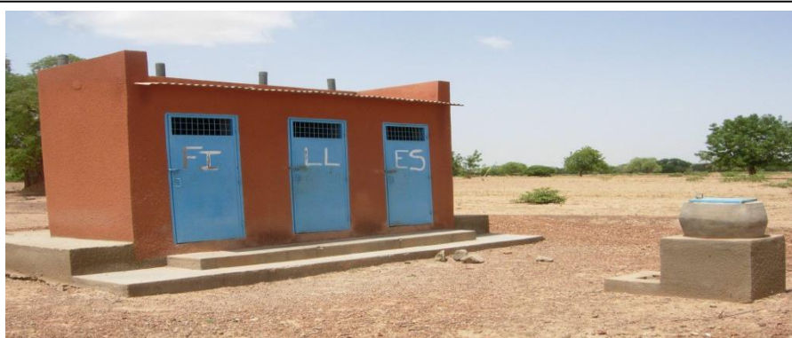
Image 1 : Un compartiment de latrines séparé pour les filles avec une installation de lavage des mains à proximité (Burkina Faso)
