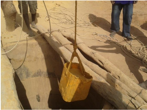
Surcreusement sur 6m de profondeur Fin novembre 2014
