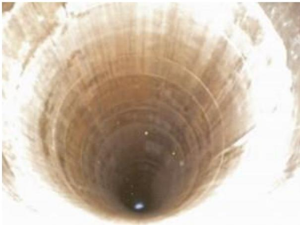
*45 m de profondeur, entièrement cuvelé, 5m de profondeur de tirant d'eau en période sèche*
